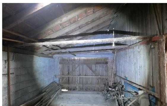
Abbildung 5: angebauter Lagerraum aus Betonstein und einem Ziegeldach ohne Dämmplatten
