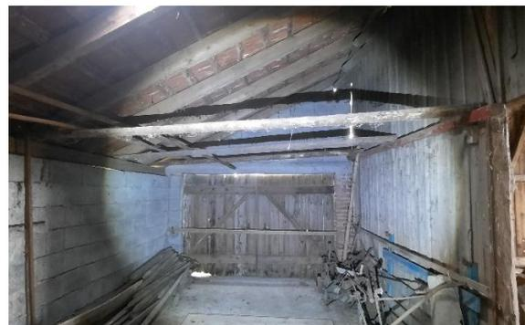
Abbildung 5: angebauter Lagerraum aus Betonstein und einem Ziegeldach ohne Dämmplatten
